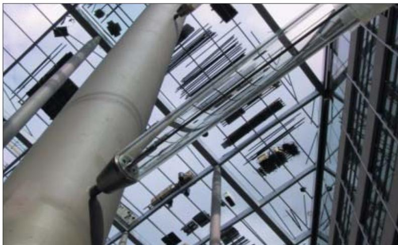
**VERBUNDGLASROHR ALS KONSTRUKTIVES ELEMENT**
